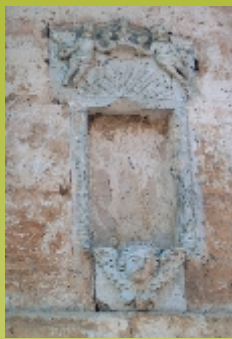
Niche au 57 rue de Bar
